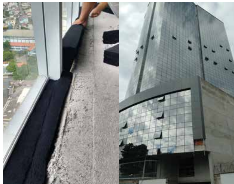
Sistema fachada pele de vidro (Lion Medical Center - Itajaí - SC)
